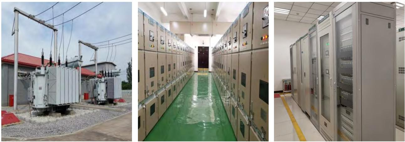
变电站型IPS小电流接地保护装置已在国网朝阳供电公司66千伏西郊变站投入使用，其保护范围覆盖18条10千伏线路，装置保护功能全部启用，跳闸压板暂为退出状态。当发生10千伏系统接地故障时，IPS小电流接地保护装置将故障选线信息发送至调度端，调度人员可以此为依据进行遥控拉路。IPS小电流接地保护装置投运后2个月内，成功检测接地故障3次，调度监控系统信息与现场查明故障点信息均核对一致，直接验证了小电流接地保护装置动作的正确性，选线正确率100%（具体报道详见“国网辽宁电力”公众号文章，网址：<https://mp.weixin.qq.com/s/oceKRfY3XSz2qZck3qqeoQ>）
