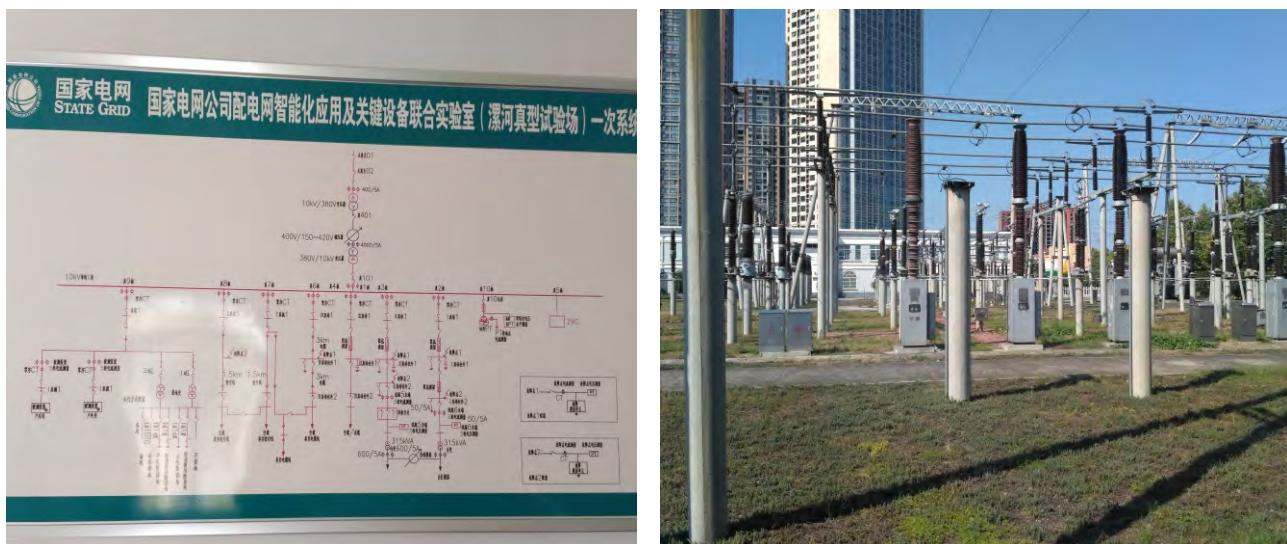
真型试验场一次系统接线图及现场设备
