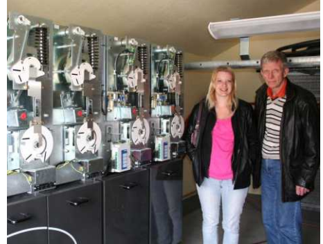
瑞典新能源工程配电项目
